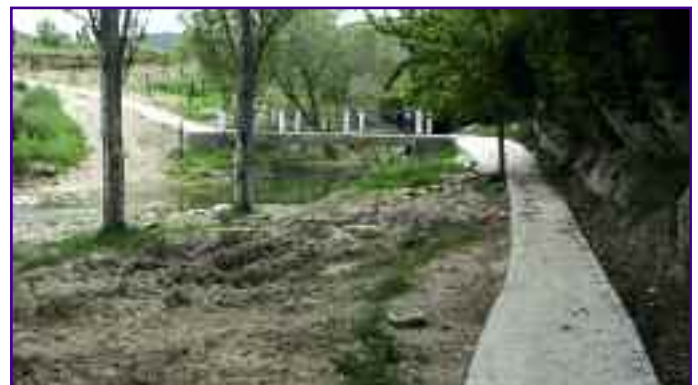
Tres imágenes del estado actual de la zona, tras los trabajos.
