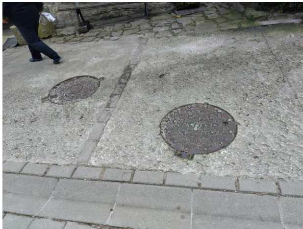
Pozo casa Mateo
