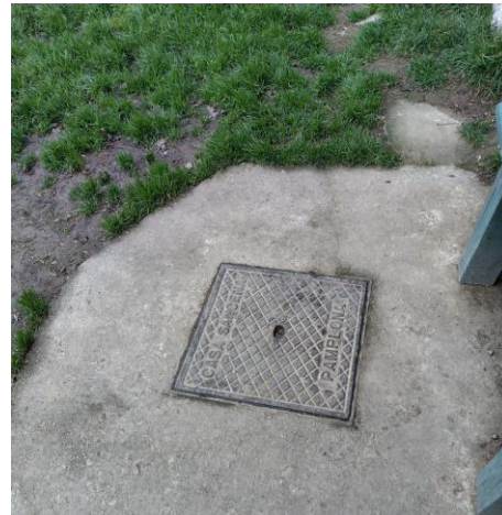
Pozo casa Txantxo
